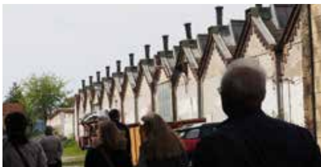
Außenansicht der markanten Sheddächer
