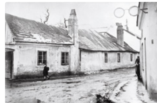
Blickrichtung Westen: Das Halterhaus war im Jahr 1930 bereits in schlechtem Zustand
