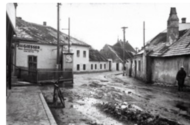
Blickrichtung Osten: In dieser Aufnahme aus dem Jahr 1927 sind noch die zwei Träger für das Mauttor in Richtung Baden erkennbar
