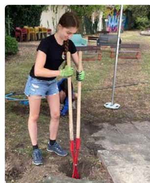
Isabelle hebt Erde für die Fundamente aus
