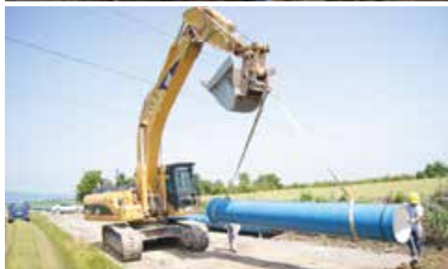
Bauarbeiten für die Zukunft: Neuer Hochbehälter und Rohrleitungen stärken die Wasserversorgung in unserer Region
