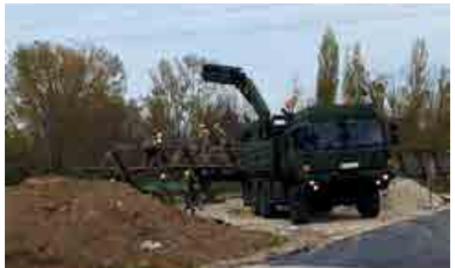
Die Brücke wurde mit einem Kran von der Seite der Stadtrandsiedlung rausgehievt und wurde dann von den Pionieren in ihre Einzelteile zerlegt.
