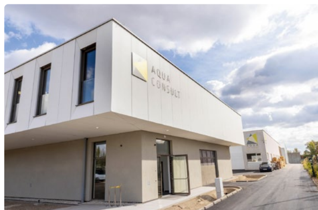
AQUACONSULT Anlagenbau hat rund fünf Millionen Euro in seine neue Firmenzentrale in der Traiskirchner Badener Straße investiert. Der Neubau bietet mehr Platz für Büros, Lagerhaltung sowie Forschung und Entwicklung.
